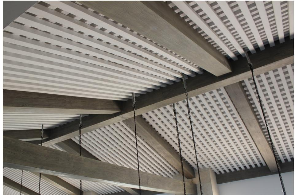
Techumbre de fibra de vidrio acabado blanco brillante y recubrimiento de vigas en fibra de vidrio acabado madera.
