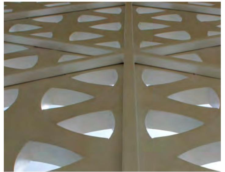
Fachada en fibra de vidrio con estructura de acero
