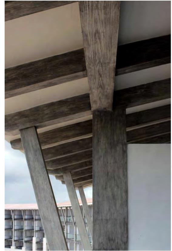
Recubrimiento de vigas y columnas en fibra de vidrio acabado madera
