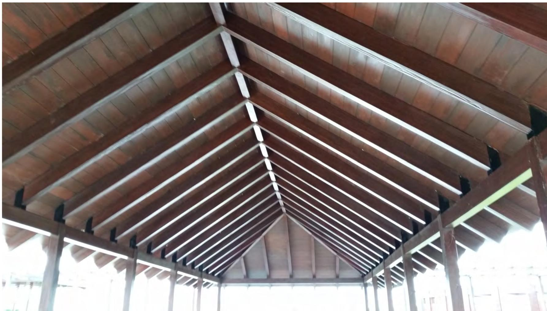
Palapa con estructura metálica en fibra de vidrio y cubierta en GFRC acabado madera.
