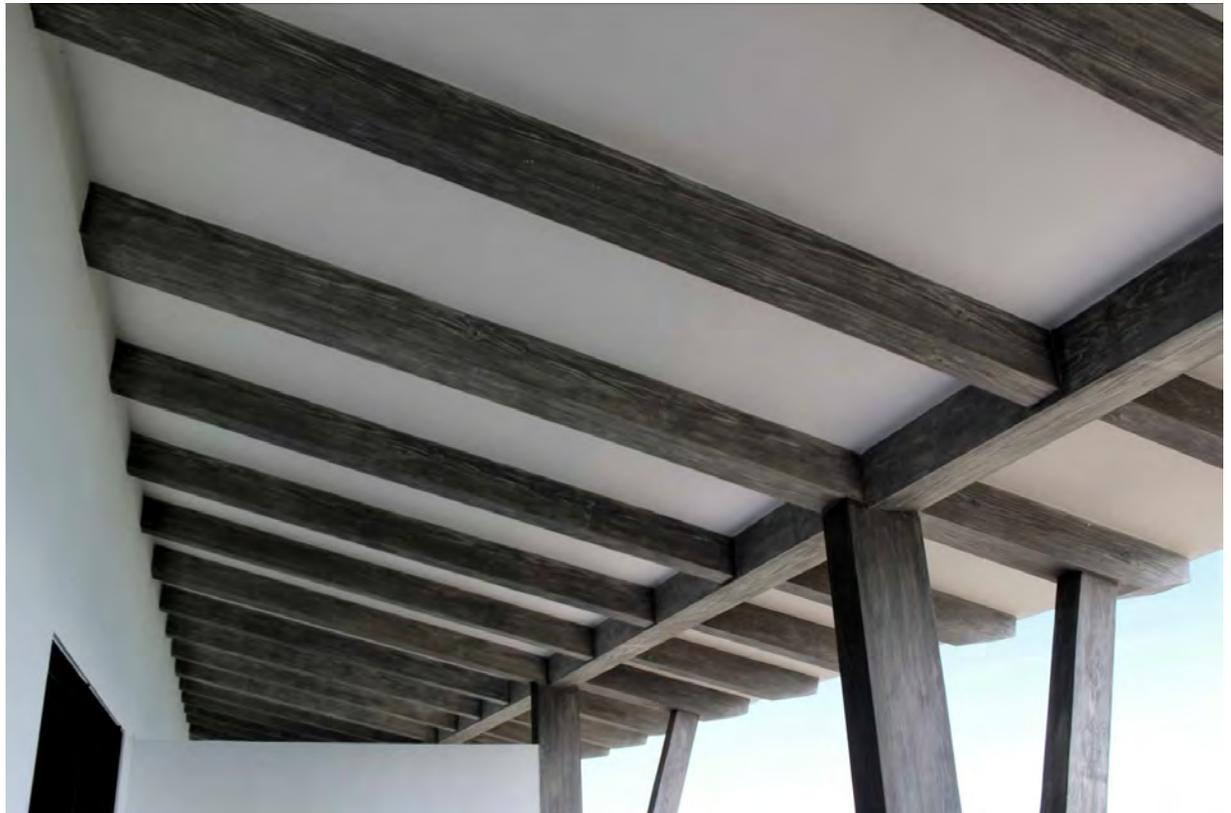
Recubrimiento de vigas y columnas en fibra de vidrio acabado madera
