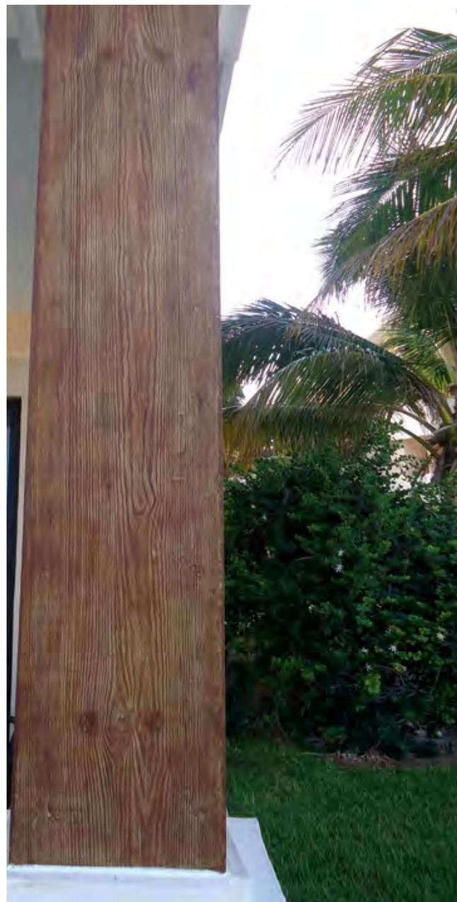
Revestimiento de columna en fibrocemento (GFRC) acabado madera
